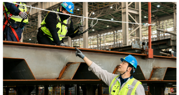
고소작업 전 생명줄과 안전대 체결 상태를 확인하는 모습
