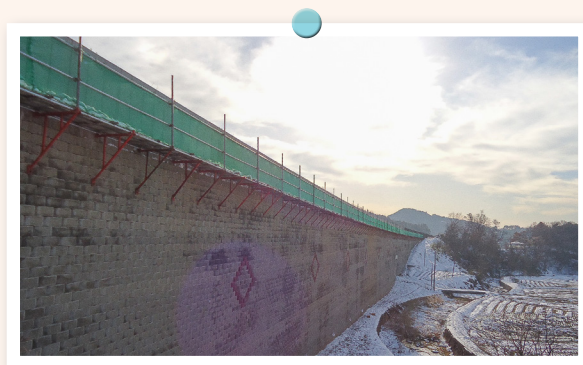
가설비계에 브래킷을 활용한 발판을 설치한 모습
