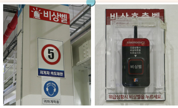
(좌) 응급상황 비상벨 및 지게차 속도제한 표지판 (우) 위급상황 비상벨(안전관리자에게 자동 SMS 발송)
