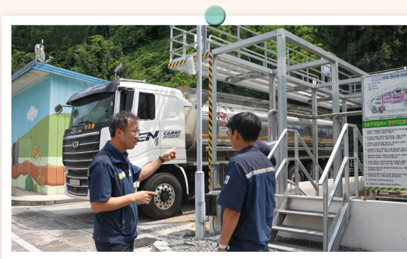
2023년 설치한 탱크로리 입하장 추락방지 시설
